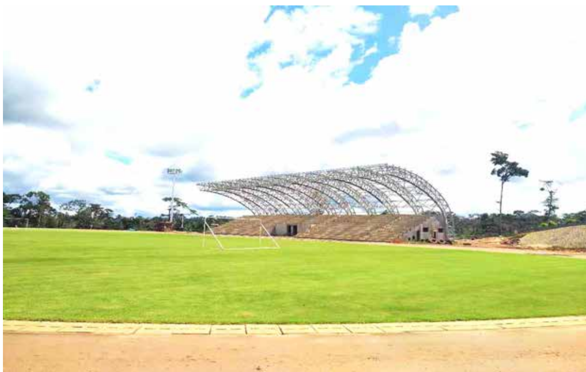
Gradins du grand stade de football en construction.
