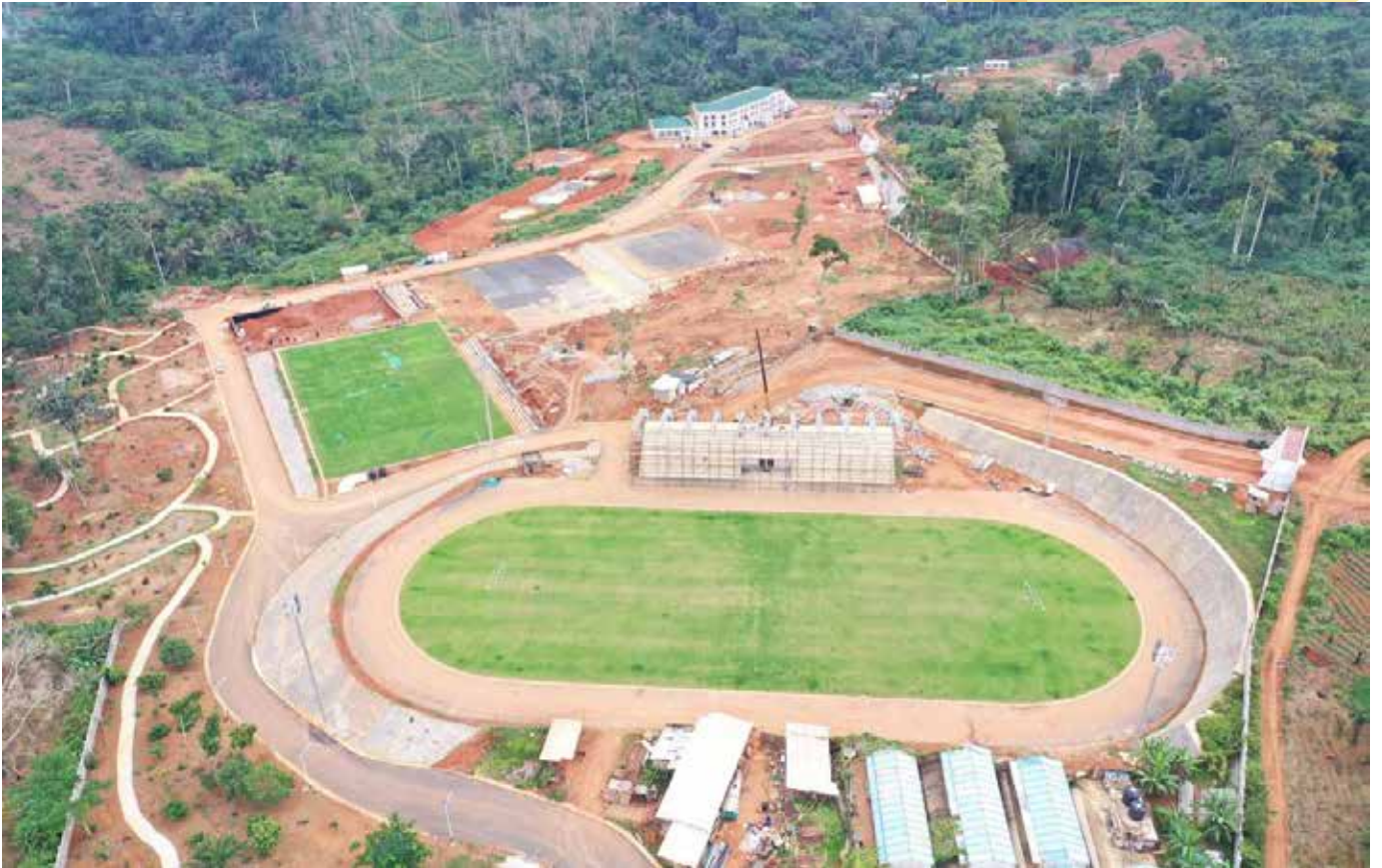
Vue aérienne du Club multifonctionnel de la MUNDI.
