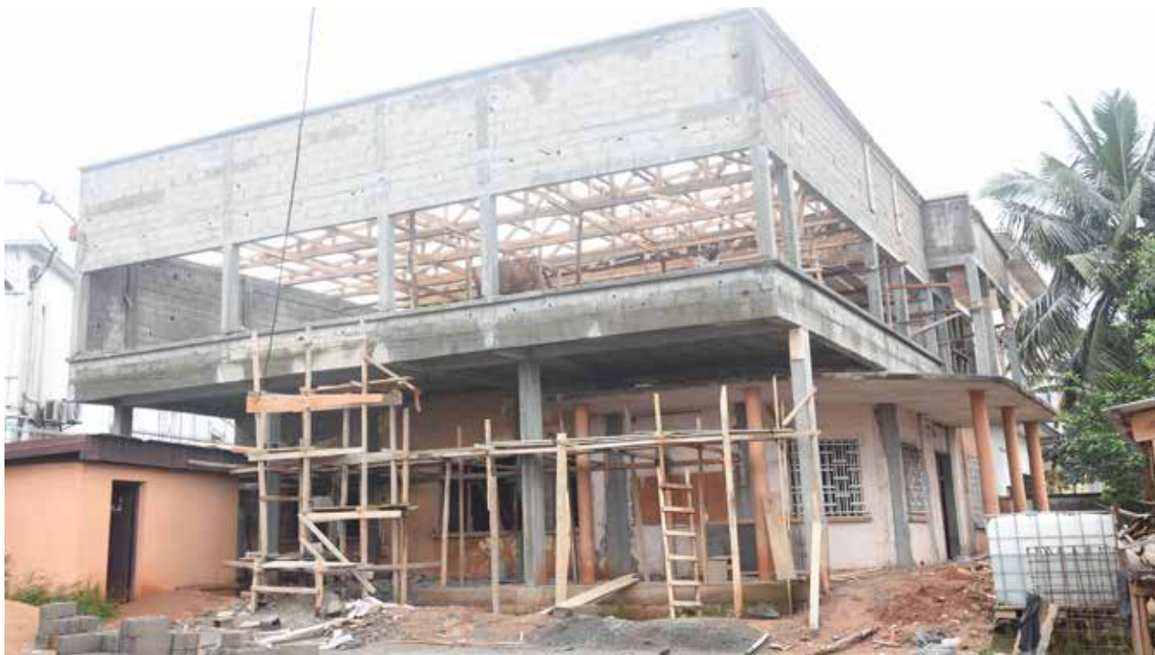
Chantier du Centre de perfectionnement et de la formation continue.
